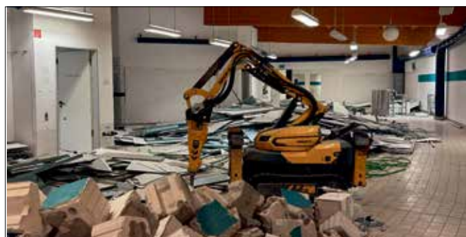
Foto: Kur & Tourismus GmbH Bad Frankenhausen
