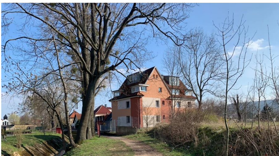
Bebauung des Stadtgebietes im Bereich Bachmühlenweg und Weidengasse, angrenzend an das Plangebiet
