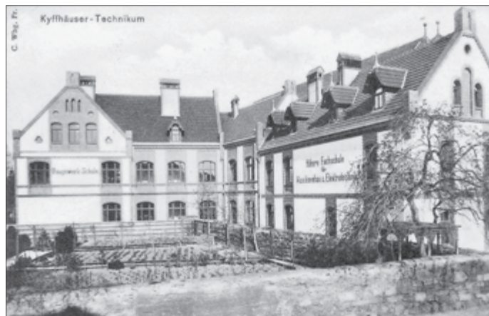
Das ehemalige „Kyffhäuser-Technikum“ am Standort des Zisterzienserinnenklosters Frankenhausen mit altem Klostergarten um 1903.
